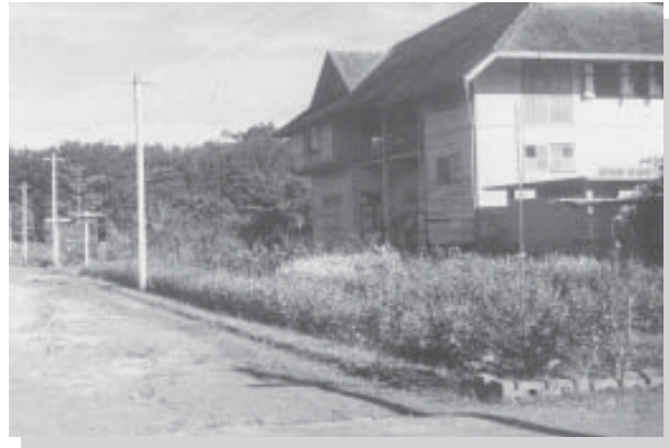
อาคารเหลืองปัจจุบัน
