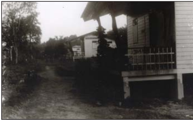
บ้านพักอาจารย์
